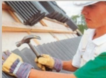
**4** Черепица на стрехах крепится оцинкованными гвоздями или саморезами, остальная просто выкладывается.
