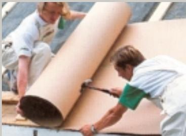
**1** Подстил ELKATEK монтируется в горизонтальном направлении прямо на стропила и прикрепляется скобами, гвоздями для толя или вентиляционными рейками.
