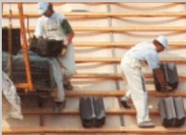
**2** Монтируется обрешетка, и проводятся вентиляционные проходы. Черепица поднимается на крышу с помощью подъемного устройства транспортной машины.
