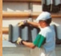
Черепица выкладывается по верхнему и нижнему рядам, выравнивается относительно стреховых свесов и нижний ряд закрепляется. Затем идет заполнение плоскости черепицей. В случае, если плоскость имеет большие размеры по горизонтали, то укладка ведется от центра вправо и влево.
