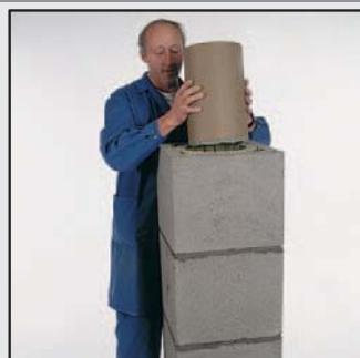
28 Установите внутрь и выровняйте керамическую трубу, удалите избыток массы для заделки шов и загляните шов губкой. Повторите все монтажные операции в последовательности, изложенной на рис. 25-28, до устья дымовой трубы.
