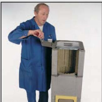
17 Блок с вырезанным отверстием установите на подготовленный раствор, излишки раствора удалите. Изоляционные панели прорежьте внутри вставьте в каменный блок. При помощи пилки отрежьте излишки изоляционного материала вдоль каналов проветривания дымохода. На верхнюю грань каменной оболочки нанесите необходимое количество раствора, используя монтажный шаблон.
