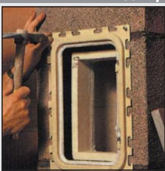
53 Дверцу снять, а раму дверцы выровнять относительно керамической рамки и прибить к блокам.
