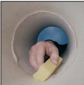
15 Избыточную массу для заделки шов после установки керамических элементов всегда удаляйте влажной губкой, а швы внутри ровните так, чтобы внутренние стени были гладкими, а шов полностью заполнен.
