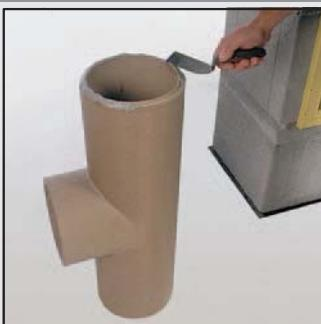
19 Нанесите шпателем массу для заделки шов на нижнюю поверхность керамического тройника для подключения потребителя.
