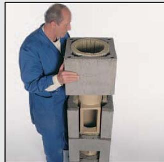
16 Вставьте два изоляционных элемента внутрь каменной оболочки. Установите каменную оболочку вместе с изоляцией на подготовленный цементный раствор. Блоки постоянно выравнивайте по уровню.
