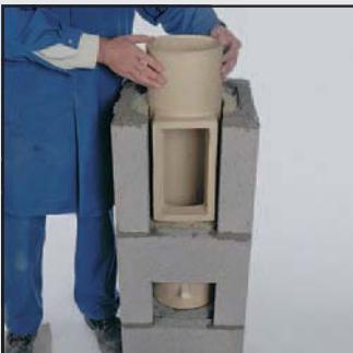
14 Установите тройник для подключения дверцы таким образом, чтобы стены тройника располагались параллельно стенкам каменной оболочки и на одинаковом расстоянии 3 см от них. Выступ на верхней грани керамической трубы должен всегда находиться снаружи, канавка внутри. Ориентация т.н. «по воде» действует для всех видов топлива.
