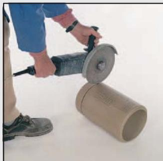
47 Обрежьте внутреннюю керамическую трубу в соответствии с нанесённым размером. На нижнюю грань керамической трубы нанесите требуемое количество массы для заполнения швов и установите внутрь каменной оболочки.
