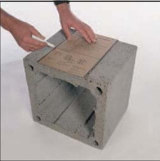
9 На следующем блоке начертите контур отверстия для дверцы, размеры которого уточните по прилагаемой таблице, входящей в состав «Основного комплекта». Угловой шлифовальной машиной вырежьте отверстие.
