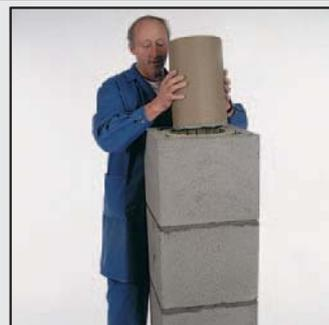
28 Установите внутрь и выровняйте керамическую трубу, удалите избыток массы для заделки швов и заглайте шов губкой. Повторите все монтажные операции в последовательности, изложенной на рис. 25-28, до устья дымовой трубы.
