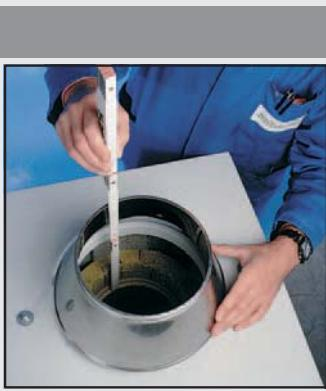
46 Установите конус и измерьте требуемую высоту последнего элемента внутренней керамической трубы.
