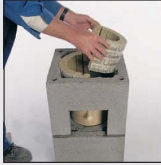
7 Следите за тем, чтобы изоляционный материал не засорял каналы вентиляции дымохода. Трубопровод для отвода конденсата выведете в отверстие вентиляционной решётки, а затем подключите к системе канализации.
