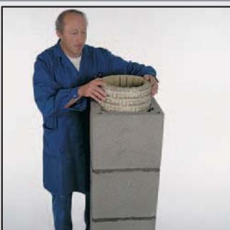
26 Изоляционные плиты согните, вставьте внутрь каменной оболочки и вместе опустите вниз. Изоляционные панели устанавливаются всегда до монтажа внутренних керамических элементов.
