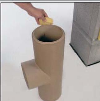
18 Очистите нижнюю грань тройника для подключения потребителя и в случае использования сухой массы для заделки шов смочите влажной губкой.
