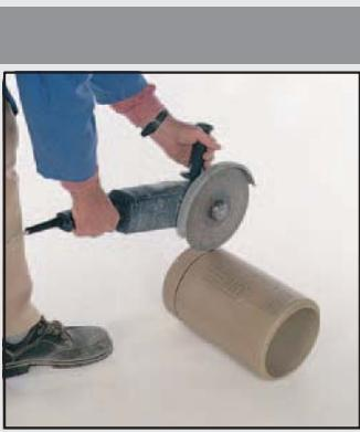
47 Обрежьте внутреннюю керамическую трубу в соответствии с нанесенным размером. На нижнюю грань керамической трубы нанесите требуемое количество массы для заполнения швов и установите внутри каменной оболочки.
