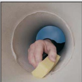
21 После установки тройника удалите влажной губкой излишки массы для заделки швов, а швы внутри выравнивайте так, чтобы внутренние стенки были гладкими, а шов полностью заполнен.
