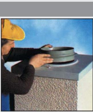
45 На покровную плиту готового элемента верхней части дымохода установите распорное кольцо. Перед установкой нанесите на кольцо герметик.
