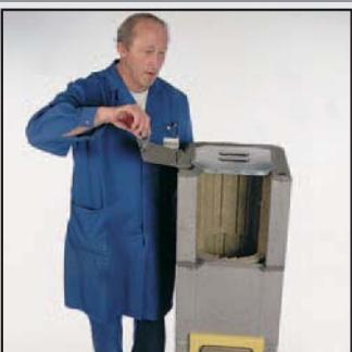
17 Блок с вырезанным отверстием установите на подготовленный раствор, излишки раствора удалите. Изоляционные панели прорезями внутрь вставьте в каменный блок. При помощи пилки отрежьте излишки изоляционного материала вдоль каналов проветривания дымохода. На верхнюю грань каменной оболочки нанесите необходимое количество раствора, используя монтажный шаблон.
