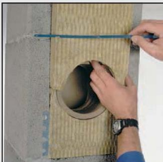
29 Установите переднюю панель из минеральной ваты между керамическим тройником и каменной оболочкой. Уменьшите высоту передней панели при помощи пилки.
