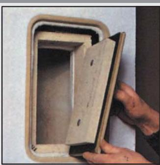
55 Внутреннюю часть дверцы окончательно устанавливаем после затвердевания штукатурки.
