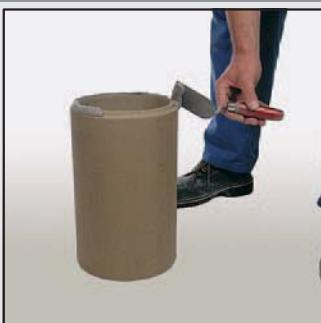
27 Нанесите смесь для заделки шов на нижнюю грань внутренней керамической трубы.
