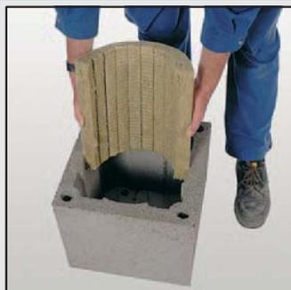
22 Изоляционные плиты согните, как показано на рисунке. Место соединения двух изоляционных элементов должно располагаться посередине одной из сторон каменной оболочки.
