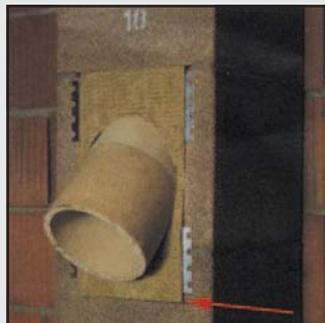
31 При использовании твёрдого топлива применяйте керамический элемент для подключения дымового канала под углом 45°. Для его установки вырежьте при необходимости два блока. По всему периметру керамического элемента всегда должен сохраняться промежуток между блоком и керамическим элементом минимум в 3 см.
