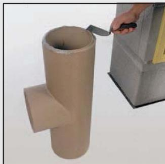
19 Нанесите шпателем массу для заделки швов на нижнюю поверхность керамического тройника для подключения потребителя.
