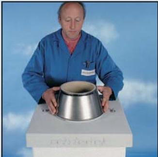
49 Оденьте конус на распорное кольцо. Используйте его как средство измерения для определения высоты верхнего керамического элемента. Обрежьте трубу до требуемого размера и установите.
