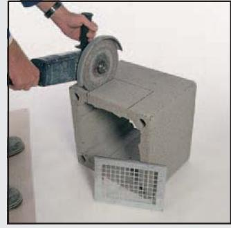
4 При помощи угловой шлифовальной машины вырежьте в следующем блоке отверстие для вентиляционной решётки.
