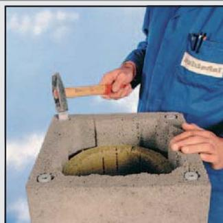
43 При монтаже готовой покровной плиты установите добели в отверстия верхней каменной оболочки.
