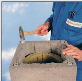
43 При монтаже готовой покрывной плиты установите дюбели в отверстия верхней каменной оболочки.
