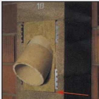
31 При использовании твёрдого топлива примените керамический элемент для подключения дымового канала под углом 45°. Для его установки вырежьте при необходимости два блока. По всему периметру керамического элемента всегда должен сохраняться промежуток между блоком и керамическим элементом минимум в 3 см.
