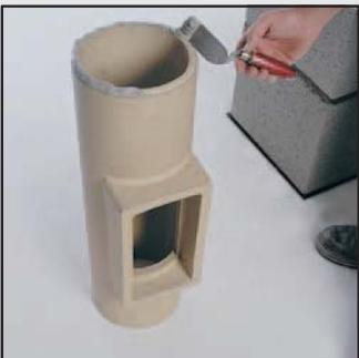
13. Перед началом монтажа всегда очищайте оба конца керамической трубы. В случае использования сухой массы для заделки шов смочите оба конца трубы влажной губкой. Нанесите шпателем массу для заделки шов на нижнюю поверхность керамического тройника для подключения дверцы.
