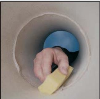
21 После установки тройника удалите влажной губкой излишки массы для заделки шов, а швы внутри выровняйте так, чтобы внутренние стени были гладкими, а шов полностью заполнен.
