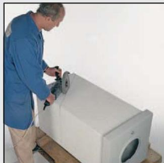
39 Перенесите все размеры на поверхность готового элемента, а затем угловой шлифовальной машиной отрежьте наружную оболочку FBK.
