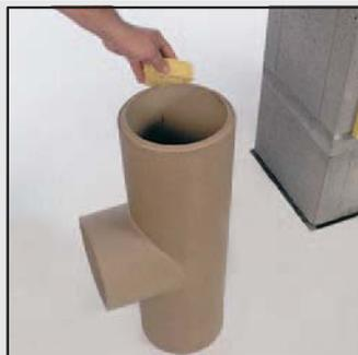
18 Очистите нижнюю грань тройника для подключения потребителя и в случае использования сухой массы для заделки швов смочите влажной губкой.
