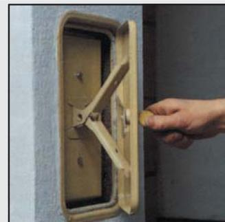
56 Удалить транспортный фиксатор с рычага дверцы и прижать внутреннюю часть дверцы путем закрытия наружной дверцы.
