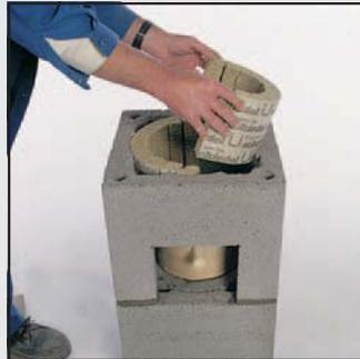
7 Следите за тем, чтобы изоляционный материал не засорил каналы вентиляции дымохода. Трубопровод для отвода конденсата выведете в отверстие вентиляционной решетки, а затем подключите к системе канализации.
