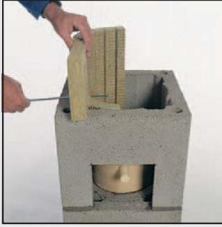
6 Согните изоляционную панель прорезями внутрь и вставьте в каменный блок так, чтобы соединение двух элементов изоляции находилось посередине задней стенки. Излишки изоляции обрежьте специальной пилкой, входящей в «Основной комплект».
