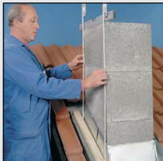
38 При применении готовых решений для оформления верхней части дымовой трубы снимите все необходимые размеры в соответствии с наклоном крыши.
