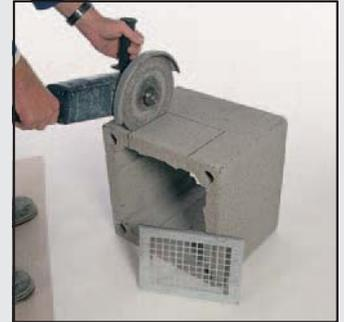
4 При помощи угловой шлифовальной машины вырежьте в следующем блоке отверстие для вентиляционной решетки.
