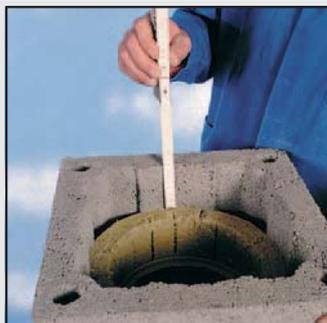
42 Изоляционный материал, устанавливаемый в верхнем блоке дымохода, необходимо обрезать так, чтобы изоляция заканчивалась на расстоянии 6 - 8 см от верхней грани блока!!!
