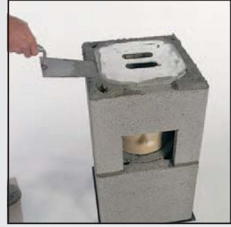
8 Используя шаблон, предохраняющий внутреннее пространство дымовой трубы вместе с каналами проветривания от попадания раствора, нанесите на блок необходимое количество раствора.
