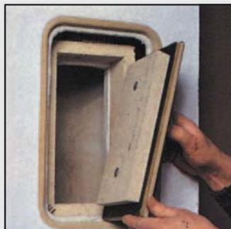
55 Внутреннюю часть дверцы окончательно устанавливаем после затвердевания штукатурки.
