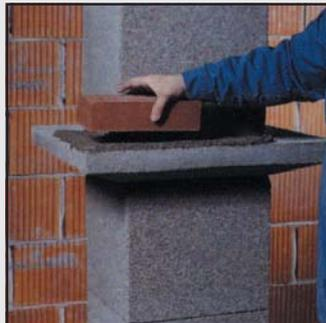
51 При облицовке кирпичом верхней части дымохода над крышей используется консольная плита, на которую затем устанавливаются последующие блоки. Консольная плита монтируется под крышей и выдерживает нагрузку от 4м кирпичной кладки. 2/3 этой конструкции находятся над крышей и 1/3 - под крышей.
