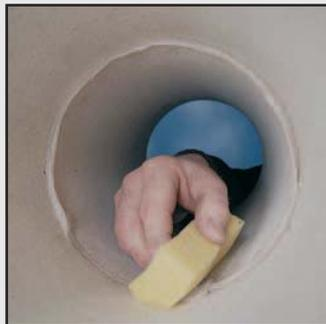
15 Избыточную массу для заделки швов после установки керамических элементов всегда удаляйте влажной губкой, а швы внутри выравнивайте так, чтобы внутренние стенки были гладкими, а шов полностью заполнен.
