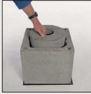
3. Установите бетонный блок-основание или залейте бетоном внутренний объём каменной оболочки. Работы с бетонной смесью вести только при температурах выше 0°C.
