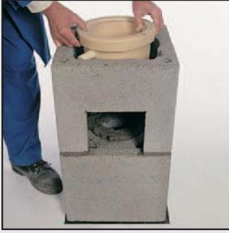
5 Блок установите на раствор на подготовленном цоколе. Выровняйте при помощи уровня. Для удобства эксплуатации разместите отверстие для подачи воздуха, а также дверцы для очистки дымохода под углом 90° к оси подключаемого потребителя. Установите ёмкость для сбора и отвода конденсата в центре блока на цементный раствор.
