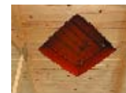
Вид внутри помещения
